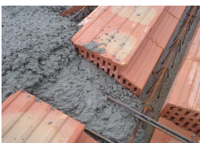
Detail stropu počas betónáže
